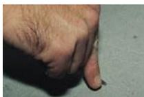
Vérifier la dureté de surface du support en le rayant avec un outil métallique pointu en plusieurs endroits. La rayure doit être superficielle.
