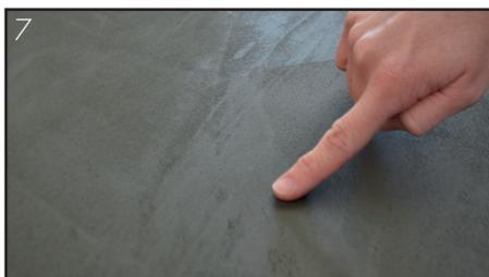
NB : Pour des angles et finitions parfaits, il est plus facile de réaliser dans un premier temps, les murs parallèles, les laisser durcir, puis de finir les autres murs dans un second temps. L'épaisseur totale des 3 couches devra être de 2mm.
